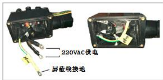
图 12 电伴热电源接线盒
